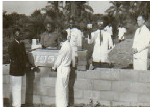
Mise de la pierre angulaire
